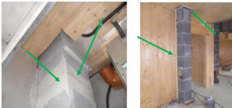
Esempi di camini previsti per combustibili solidi eseguiti correttamente: garantita adeguata distanza dai materiali combustibili con interposto materiale conforme alle specifiche del fabbricante del camino (solitamente materiale in Euroclasse A1 (incombustibile) e con conduttività termica non maggiore di 0,035 W/mK ± 0,002W/mK 1 )
